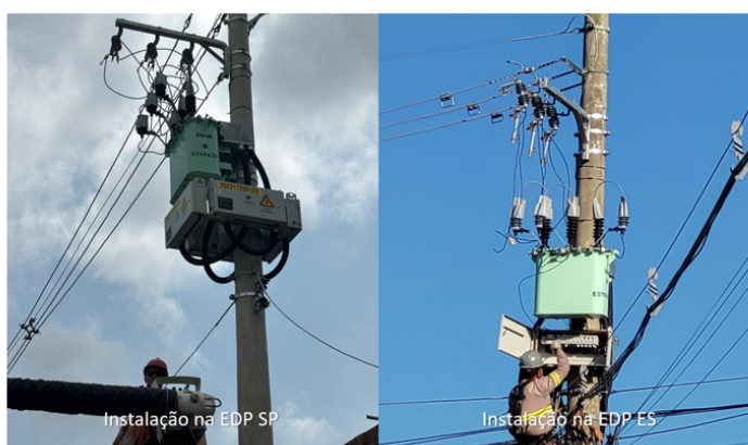
Figura 9 - Instalação dos Concentradores Secundários e do SMC Pantheon Wi-SUNFonte: Elaborado pelo autor (2025).
